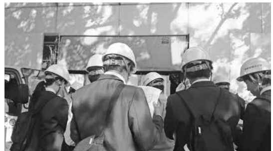
図面を見ながら建設現場へ
